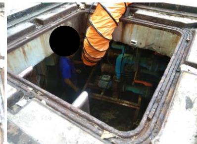
แก้ไขปรับปรุงสระว่ายน้ำเข้าทำการรื้อถอนอุปกรณ์ห้องเครื่องสระว่ายน้ำ
